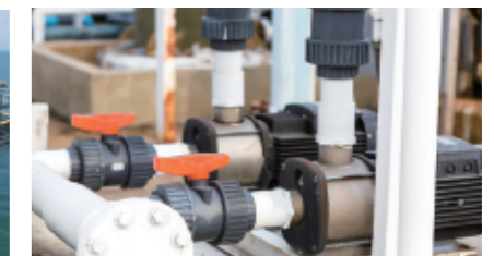
建筑工地供水
